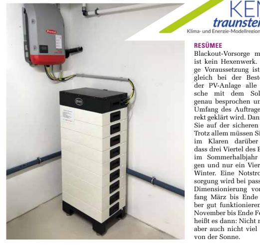
die PV-Anlage im selben Moment erzeugt. Es gilt aber auch hier: Wenn das öffentliche Netz ausfällt. dann erzeugt auch die PV-Anlage keinen Strom. Somit stellt auch eine Batterie-PV-Anlage per se keinen Blackout- Schutz dar.
