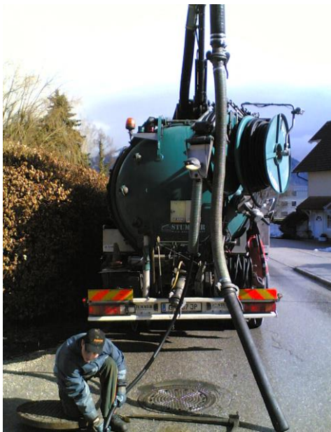
Kanal – Spülfahrzeug mit Hochdruckschlauch
